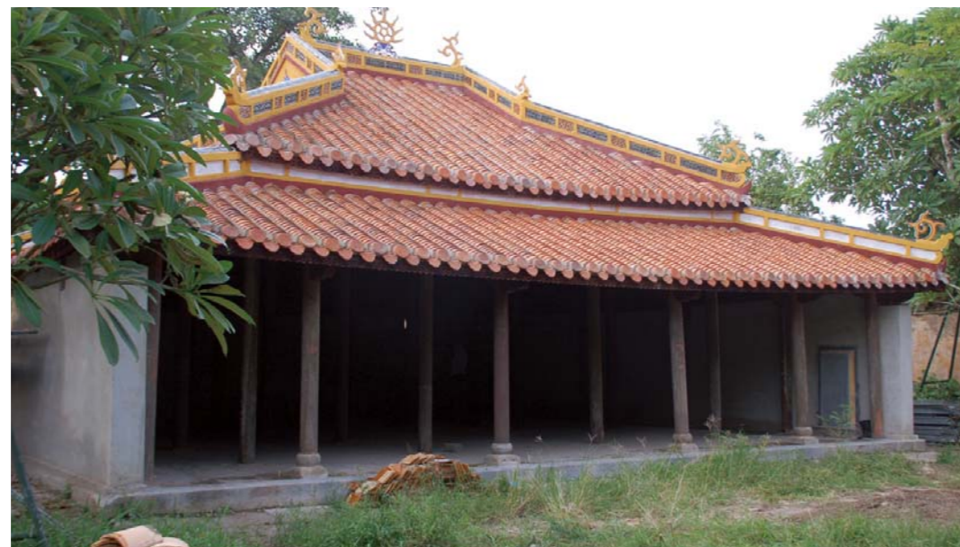
隆徳殿修理工事竣工
