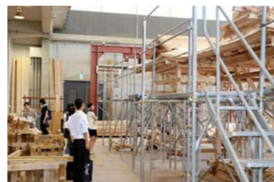
本格的な木造実習 [建設学科]
