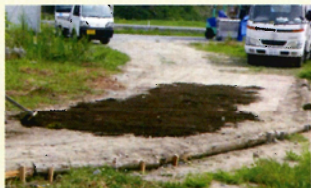
写真3 大型バス用駐車場の整備
