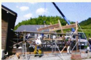
写真1 屋外屋根設置工事の状況
