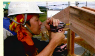
写真2 屋外屋根設置作業中の状況
