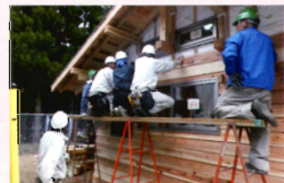
仮設談話室:壁面完成目前の状況
