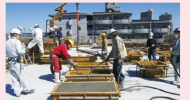
現場の様子—全体
