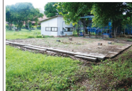
写真1:昭敬殿基壇の旧状
