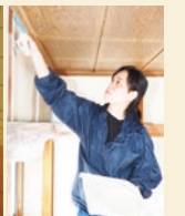
和室塗り替え左官工事
