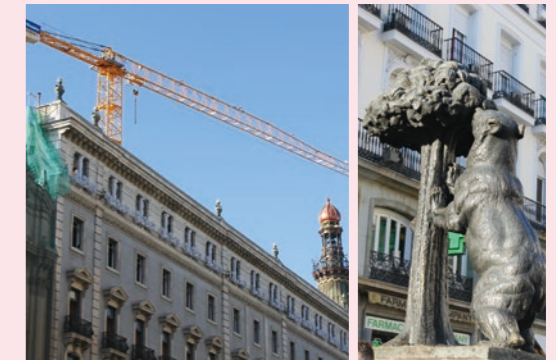
リノベーション工事中のビル(マドリッド)
