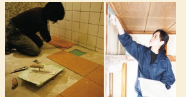
浴室タイル工事
