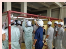
天井の下地取付
