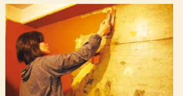
内装左官工事
