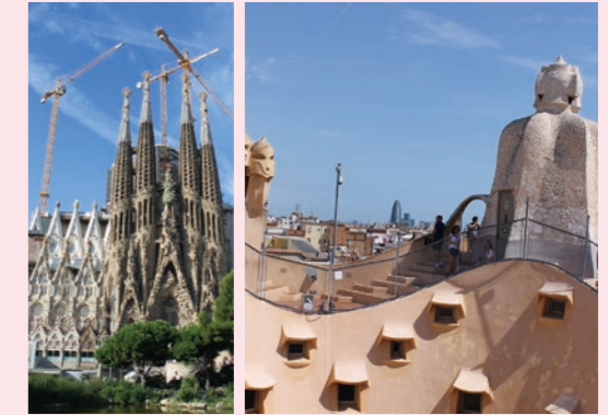
建設が進むサグラダ・ファミリア(バルセロナ)
