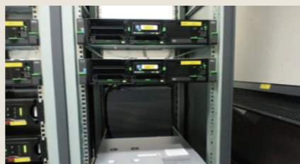
タイプⅠ:システムサーバー設置
