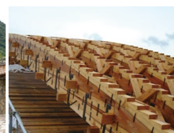
図2:桁組と金物(架替え工事の様子)
