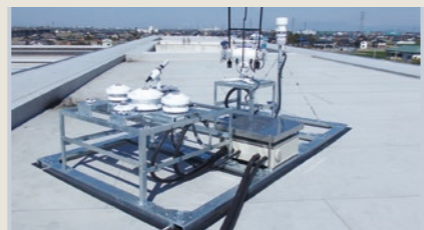
タイプⅡ:気象観測装置の設置(屋上)
