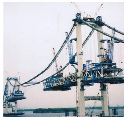
写真1: レインボーブリッジの架設状況
