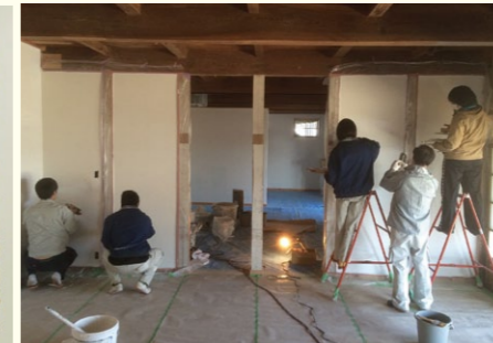
大作業後左官漆喰塗り壁作業の状況
