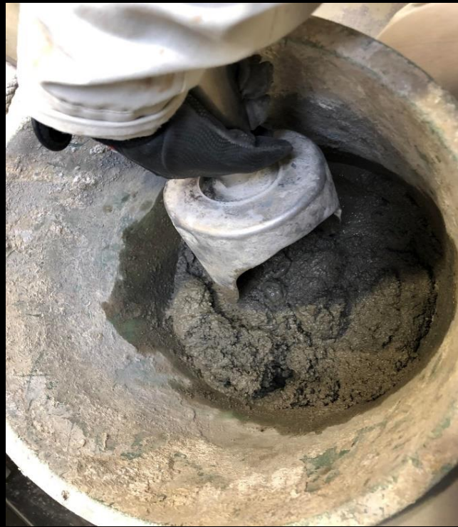
モルタルの混練
