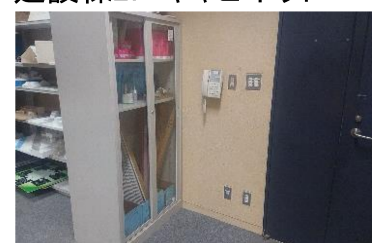
建設棟2F キャビネット
