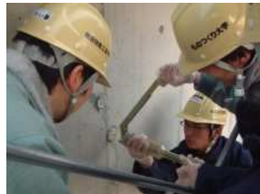
ひび割れ注入
