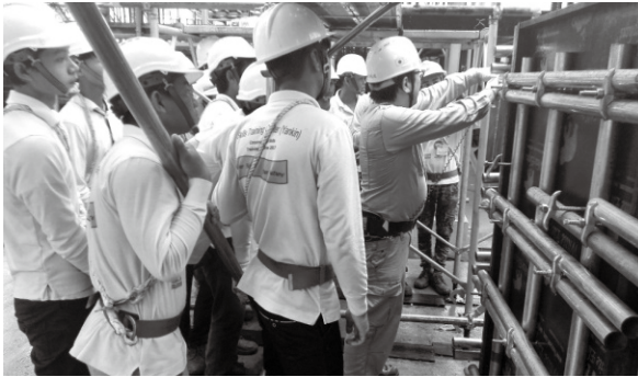
RC コース 型枠検査状況
