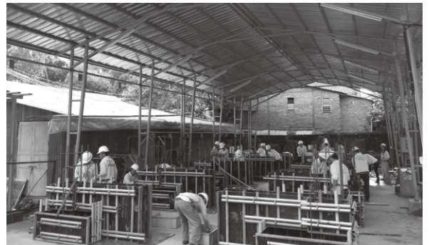
RC コース 鉄筋型枠 実技試験完了状況
