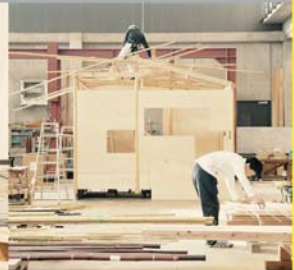
⑤ - 木仮組の様子 美術館にて本組みのため解体
