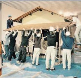
⑧ - パネル化した土間庇の取付け
