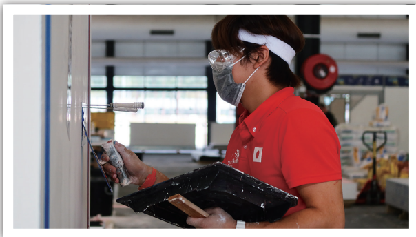
塗り付け作業
