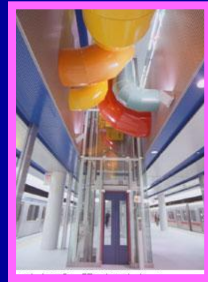
見せる空調設備のイメージ (横浜 みなとみらい線)
