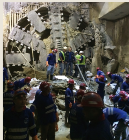
インターンシップ現場(タイの地下鉄工事)の様子(古矢)
