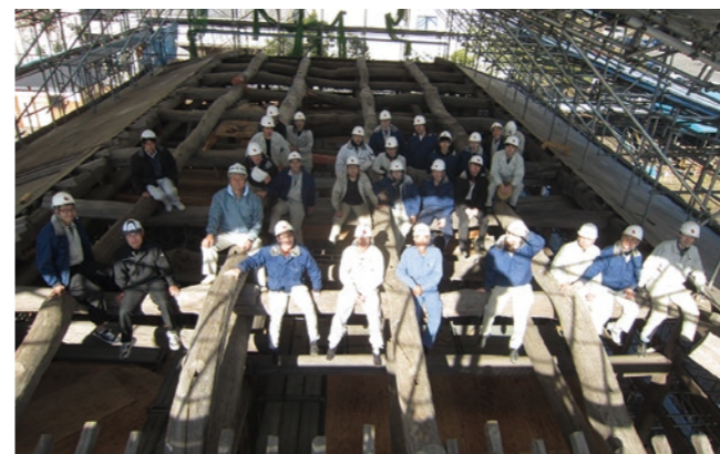
3年生木造総合実習:旧長久寺本堂修理(この建物がなくなるのは残念至極)
