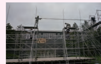
学園祭ステージ建設中
