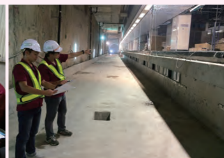
チョーカンチャーン社の地下鉄現場確認
