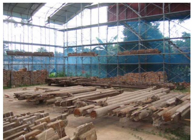
写真4 隆徳殿の解体および部材調査
