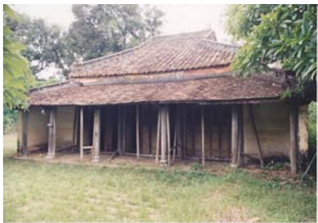
写真1 隆徳殿南面（修理前）
