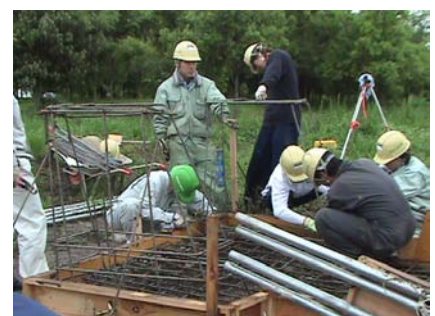
図8 アバットの鉄筋組立
