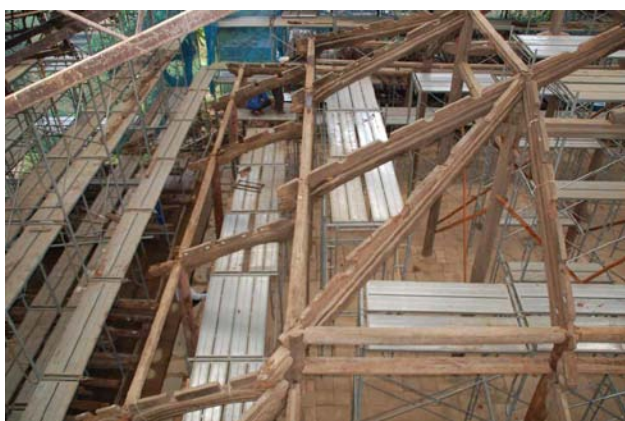
写真8 柱の伸び・内転び
