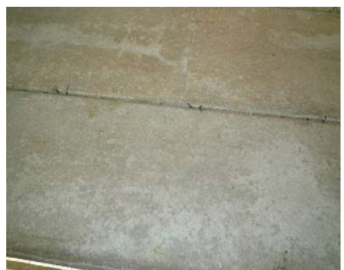
図-12 床版裏の様子
