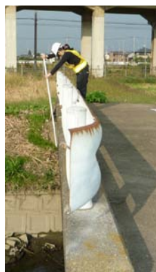
図-11 床版裏撮影風景
