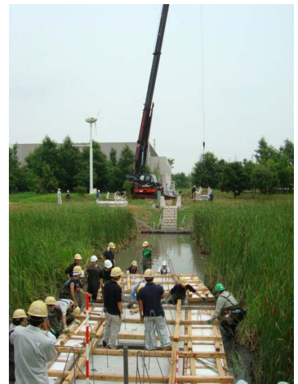
図11 浮体の設置状況
