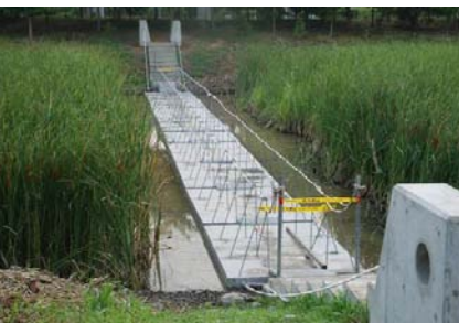
図13 浮体橋の完成
