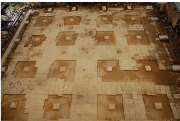
写真6 隆徳殿の基壇修理
