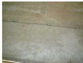
上部工 (床板裏)
