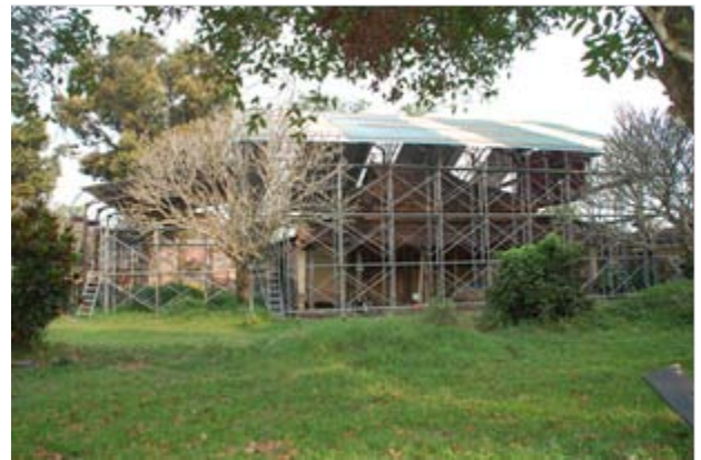
写真3 隆徳殿素屋根
