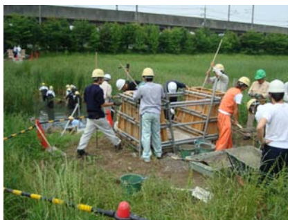
図9 アバットのコンクリート打設
