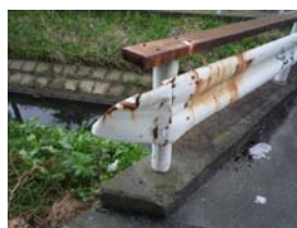
高欄ガードレールの破損
