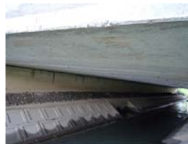
上部工 (床板裏)
