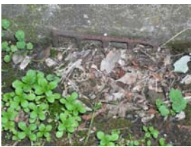
排水口の詰まり
