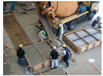
図5 浮体コンクリートの打設
