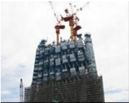
写真3 建設中のスカイツリー 1)
