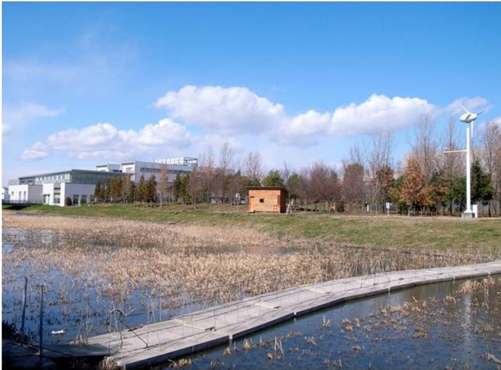
図2 地中海に見立てた池の畔に完成した休暇小屋 手前にコンクリート製の浮き橋,右に風力発電の風車が見える
