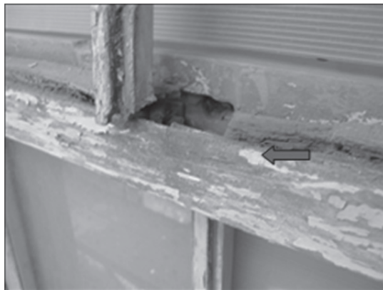
3) 窓棧素地上に残存する白色塗装痕
