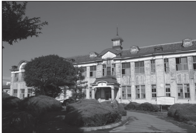
図1 修理前記念館正面写真（平成23年8月30日撮影）
