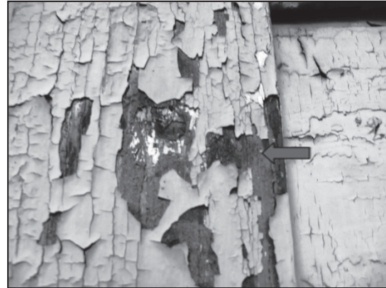
2) 窓枠に残存する緑色塗装痕跡
