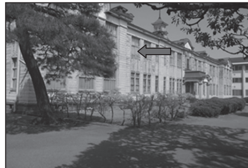
2) 修理前現状窓は上階が引違窓
