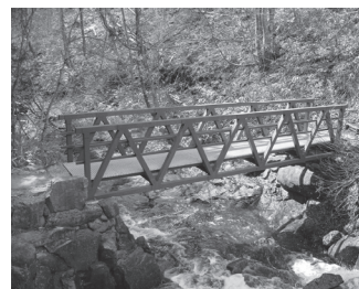
図 10 高山の GFRP 橋
