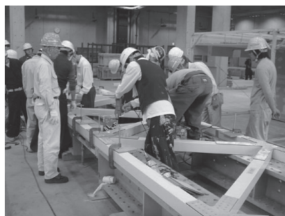
図 6 トラス桁製作
