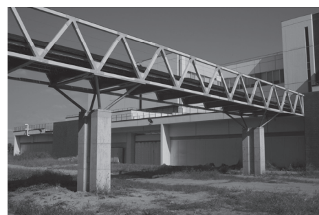
図2 第2連絡橋「野村東太橋」
