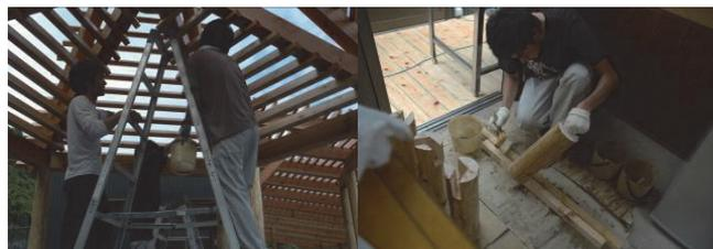
写真 17 かぶら束塗装 写真 18：間柱塗装
