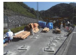
写真10 アンカー金物 写真11 基礎打設完了
