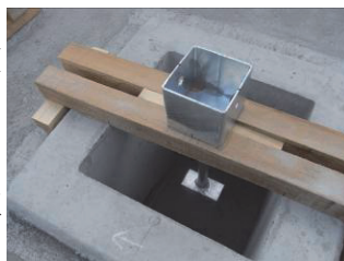
写真10 アンカー金物 写真11 基礎打設完了
