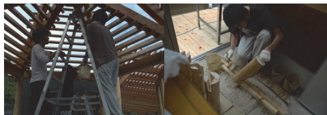
写真 17 かぶら束塗装 写真 18：間柱塗装
