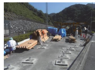
写真10 アンカー金物 写真11 基礎打設完了
