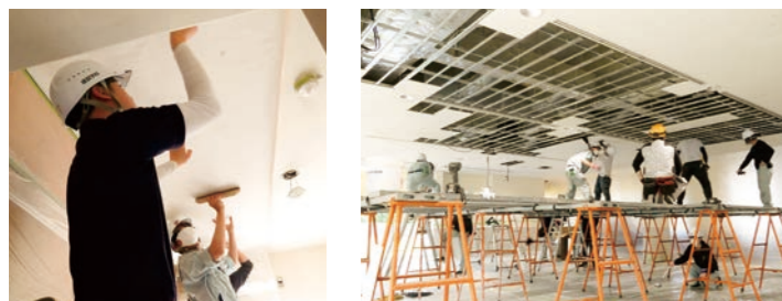
▲ドミトリの天井張り替え作業
