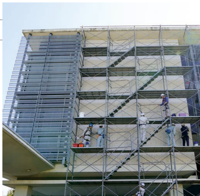
▲大学本部の外壁補修
