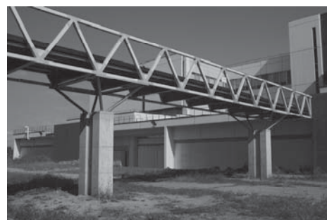
図2 第2連絡橋「野村東太橋」
