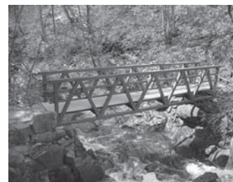
図 10 高山の GFRP 橋
