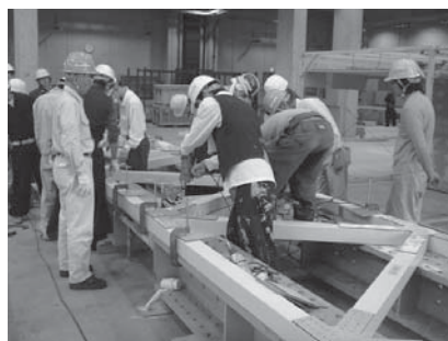
図 6 トラス桁製作
