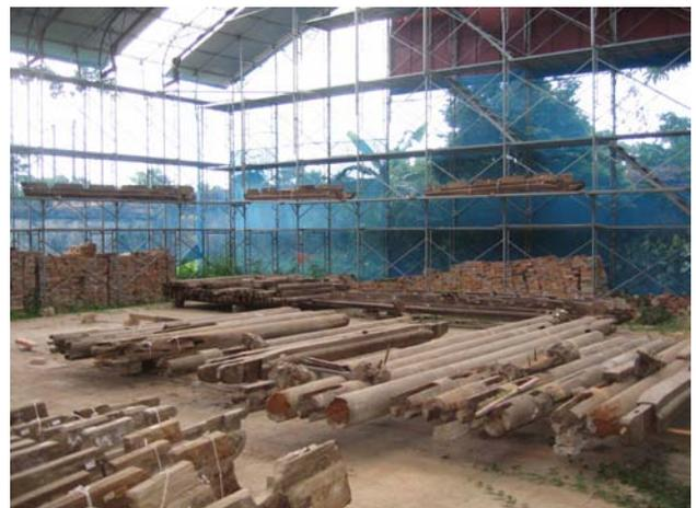
写真4 隆徳殿の解体および部材調査
