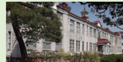
修理前 記念館正側面外観
