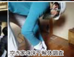
空き家の床下解体調査
