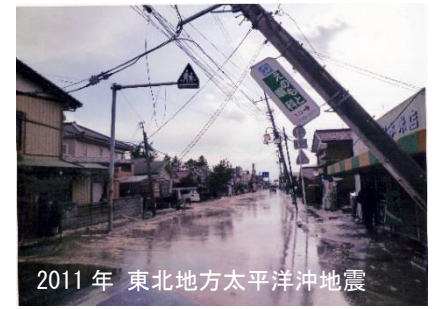
c)我孫子市都地区の液状化被害
