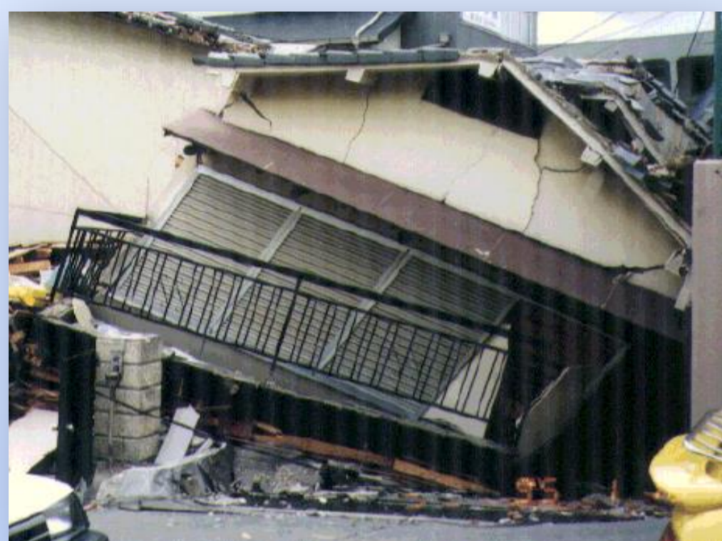
層崩壊した建物 (上下階の剛性バランス)
