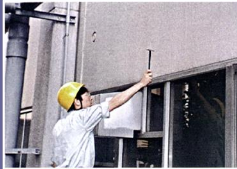
外観劣化調査
