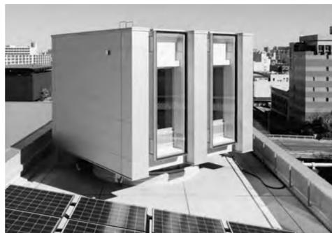
外装材の性能を正確に評価できる外装材一対比較試験室(清水建設)
