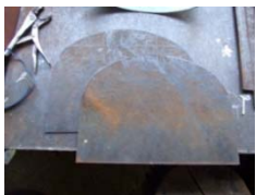
図6 部材切り出し 正面と背面を切り出す。
