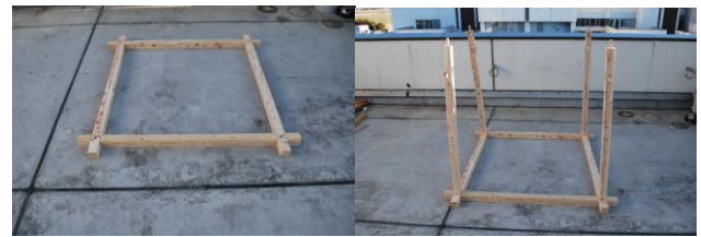
①土台組み立て ②柱組み立て
