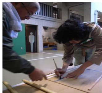
写真3 原寸図作成
