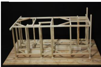
図10 梁 火打ち設置
