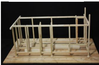
図9 土台 柱 桁設置
