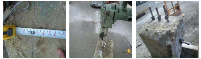
①墨付けをする ②ハンマードリルで穴を開ける ③穴に三本セリ矢を入れる
