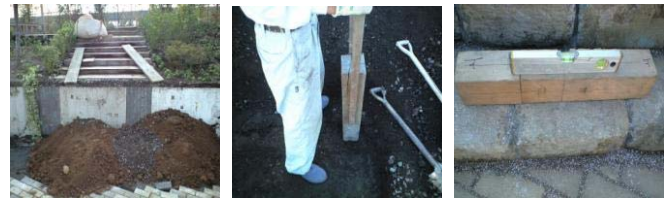
⑦土を盛る ⑧土を叩き固める ⑨石材を平行に並べ組上げていく
