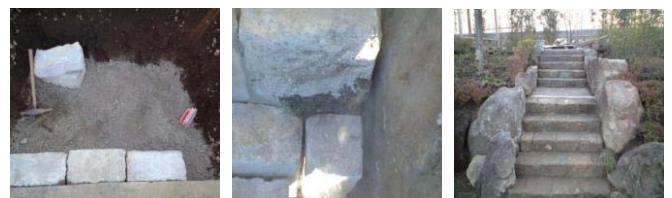
⑩踊り場は砂を敷き ⑪目地にモルタルを詰める ⑫袖石に自然石を置き据付け完了
