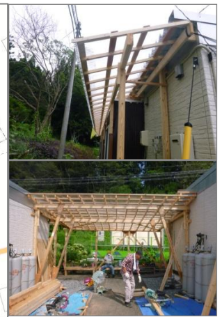
写真 上：庇 下：屋外交流スペース
