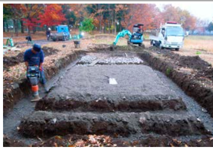
1.2 掘削・捨コン 2017. 12. 1
