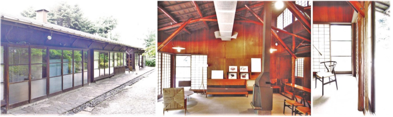
写真1 旧井上房一郎邸（左・外観 中・鉄状トラス 右・芯外しの開口）
