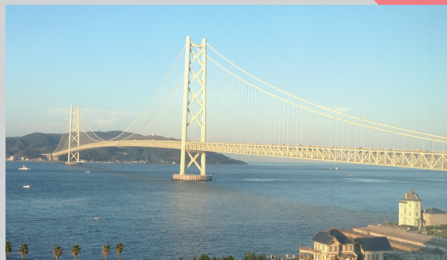
明石海峡大橋
