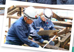
▲建物解体調査
