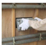
ボス型枠取付け
