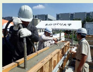
模擬壁部材へのコンクリートの打込み・締め固め
