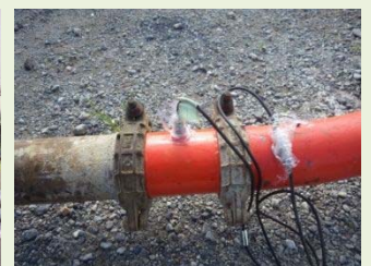
実機ポンプによる 管内圧力の測定
