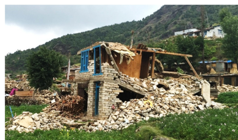
2015年ネパール地震での被害状況
