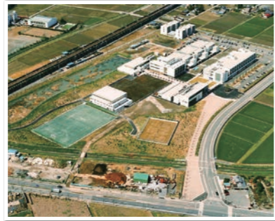
▲竣工時航空写真(2001年)
