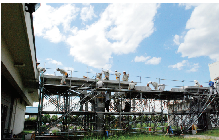
写真 3 建設学科の第 3 連絡橋の建設風景
