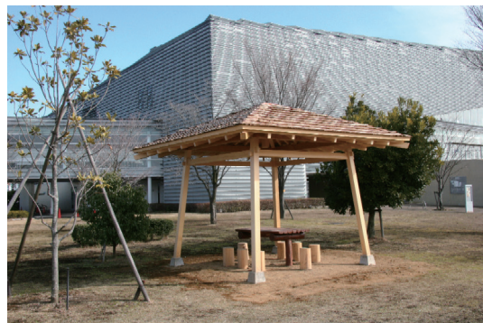
写真4 鴻巣市中央せせらぎ公園東屋
