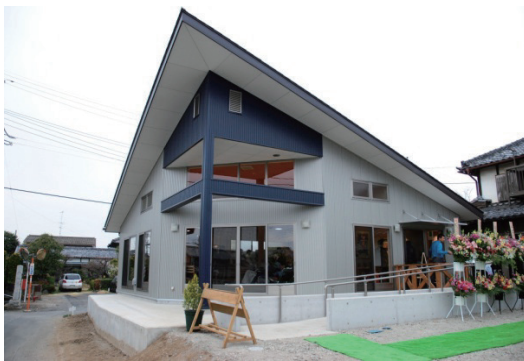
写真 7 行田市障害者多機能支援施設
