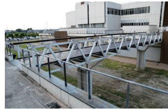
写真 21 ⑬第二連絡橋
