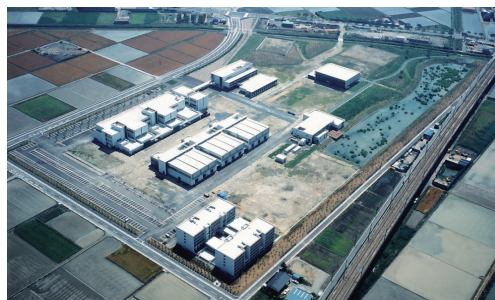
写真3 竣工時の様子
