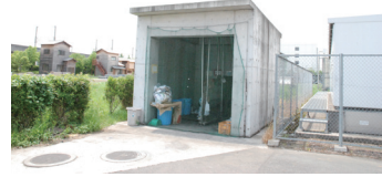
写真 14 ②ゴミ置場
