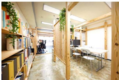
格子の木質パーテーションが応接エリアの視線をコントロールする
