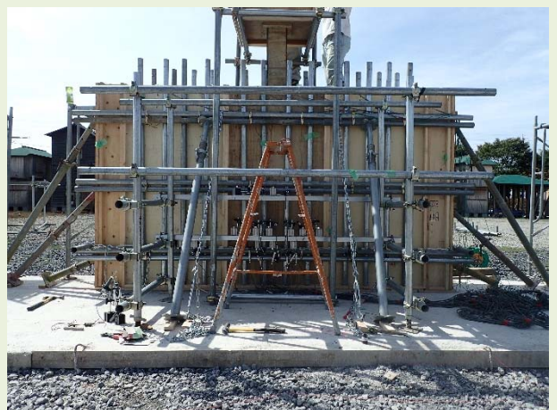
実大レベルの試験体でコンクリートの側圧と型枠の変形量を計測
