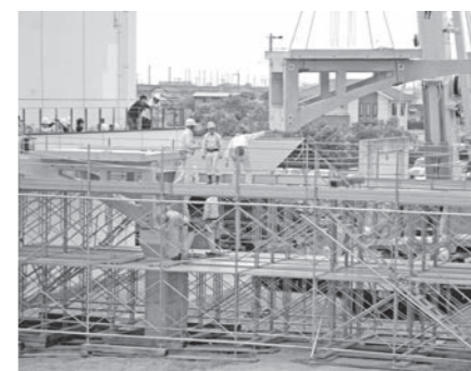
写真-4 架設の様子
