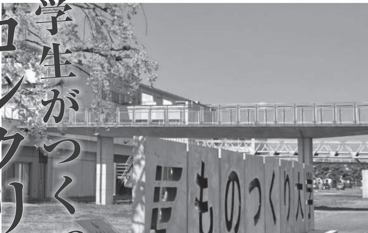
写真-1 第一連絡橋全景
