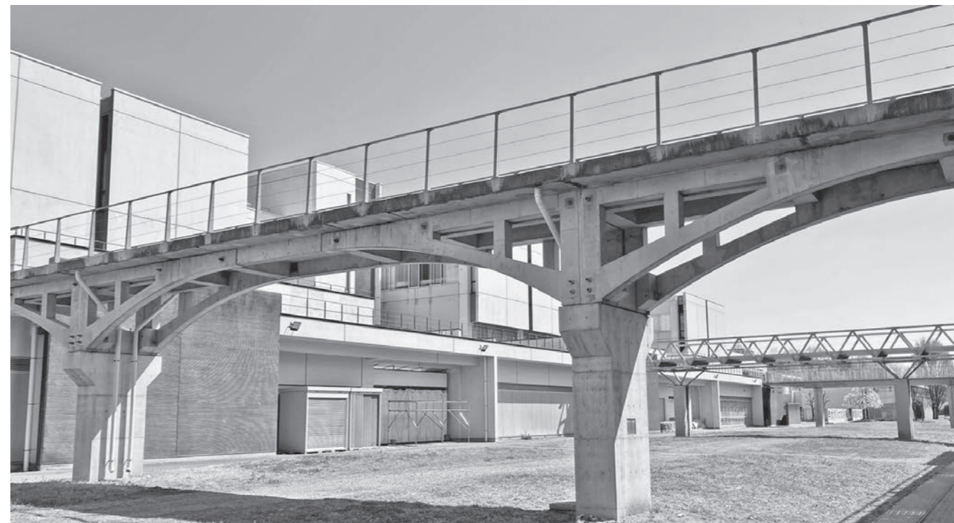
写真-2 第三連絡橋全景
