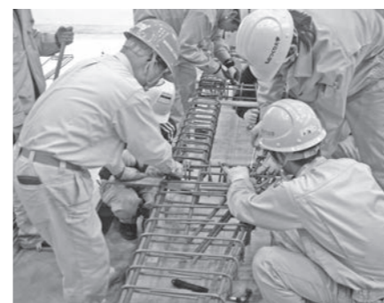
写真-3 鉄筋組立の様子
