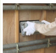
ボス型枠取付け
